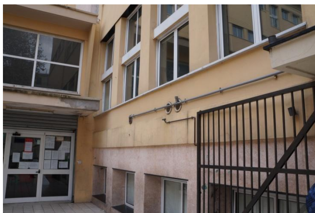
Figura 8.1 – Particolare vista esterna
