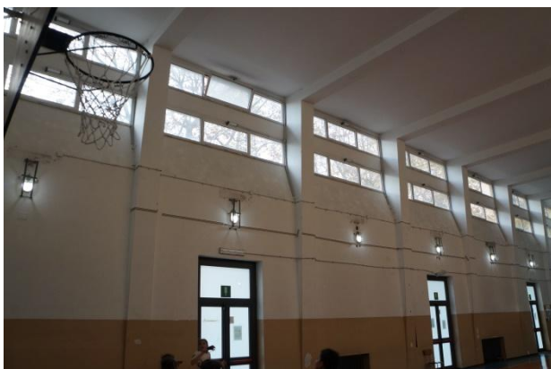
Figura 4.18 - Particolare dei corpi illuminanti ubicati nella palestra dell’edificio scolastico
