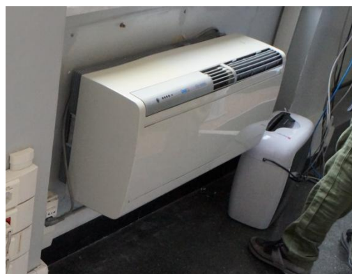
Figura 4.8 - Particolare del ventilconvettore installato all’interno degli uffici comunali
